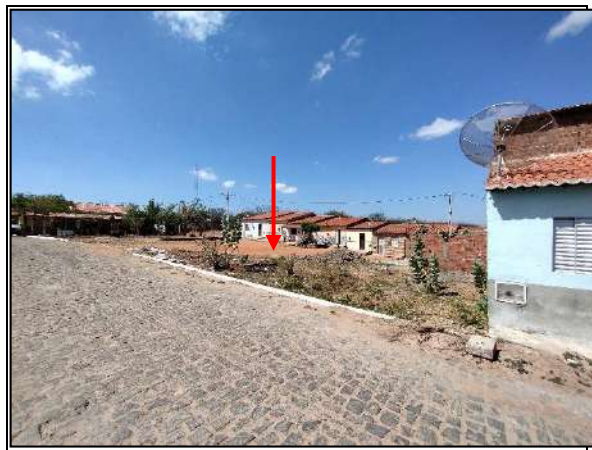
Foto 5 - Contexto do terreno objeto de proposta para construção de praça ou largo, localizado na rua Francisca Duarte, no bairro São Francisco. Baixo/CE. 12/12/23
